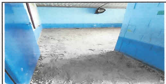
Foto 5: torta de cemento levantada y raíces desenteradas.
