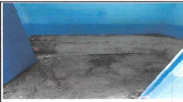
Foto 2: Baño de niños: piso levantado y tubería habilitada nuevamente.
