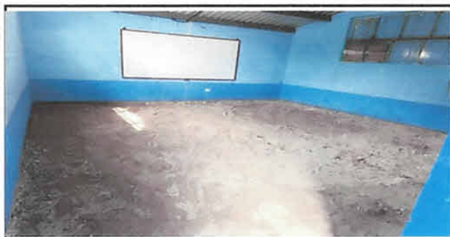
Foto 3: piso levantado de aulas y raíces desenteradas.
